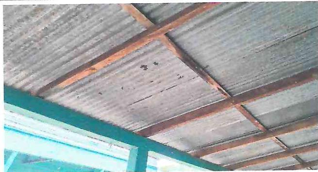
Foto 1: Lámina dañada y en mal estado
