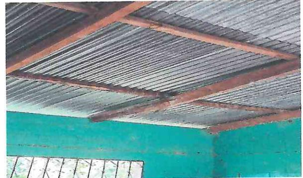
Foto 2: Estructura de madera dañada y podrida
